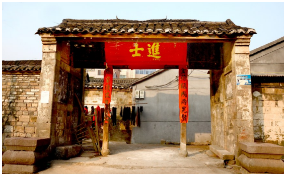
布政故里文楼村小厅
