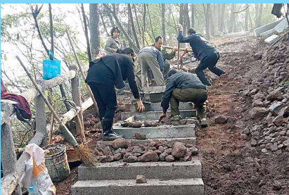
工人在铺设南岩分流游步道。
