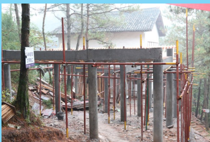
索道上站重建工程已打好根基。
