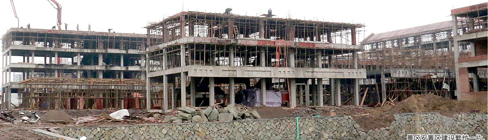
景区安置区建设繁忙一片。
