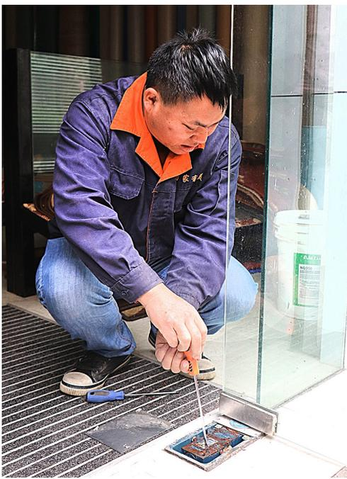
他发现地弹簧内有积水 ,锈迹斑斑 ,调节螺丝因生锈已经无法转动。
