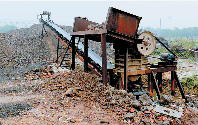
近日阴雨 ,碎石作业时扬尘减少 ,城管部门将持续关注整改效果。
