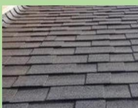
沥青瓦:造型多变,质轻安全,施工简便,但易老化、被风吹落,阻燃性不强,约25元一卷。
