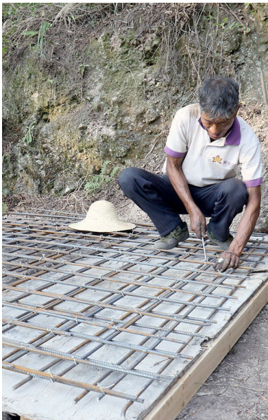
矿洞封闭工程正在施工。
