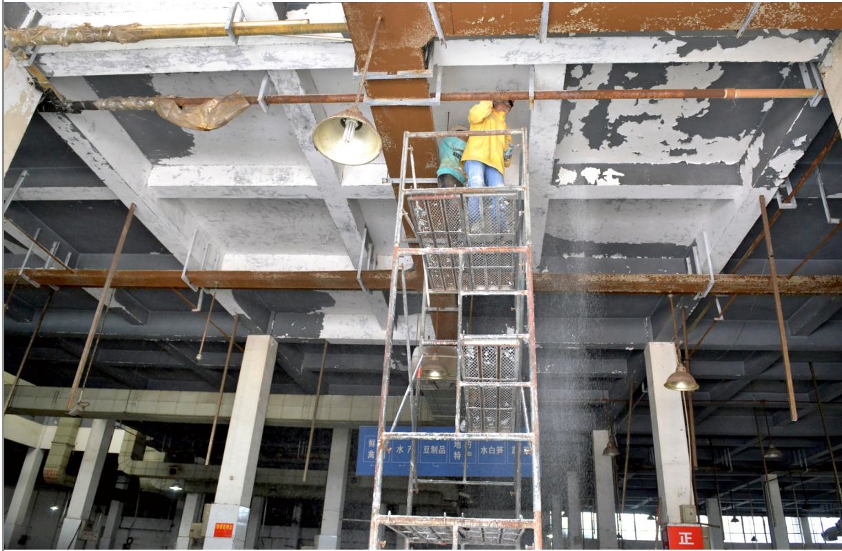
近日,华丰菜场扩容改造工程全面启动。据了解,本次扩容改造面积1万多平方,总投资600多万,工期2个月。蔬菜批发部及自产菜摊区于9月28日已搬迁到防洪渠(原双飞驾校旧址)临时菜场营业。 记者 杨成栋 摄
