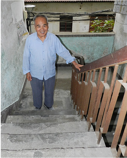
楼梯修好,住户出入放心。
