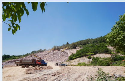
骨灰堂建设工地
