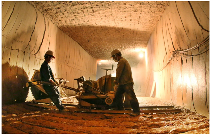
经过6年的开凿,石窟已接近完工。
