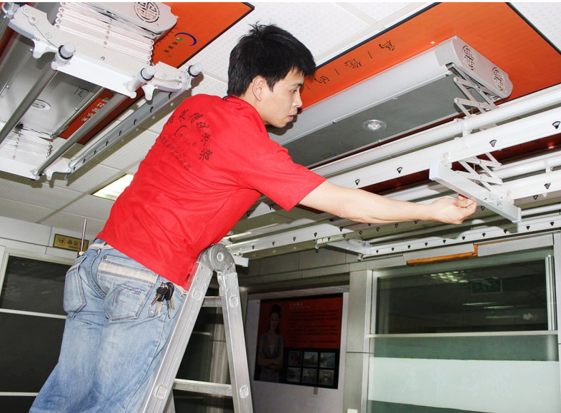
侯师傅在调试升降晾衣架。 记者 吕高攀摄
