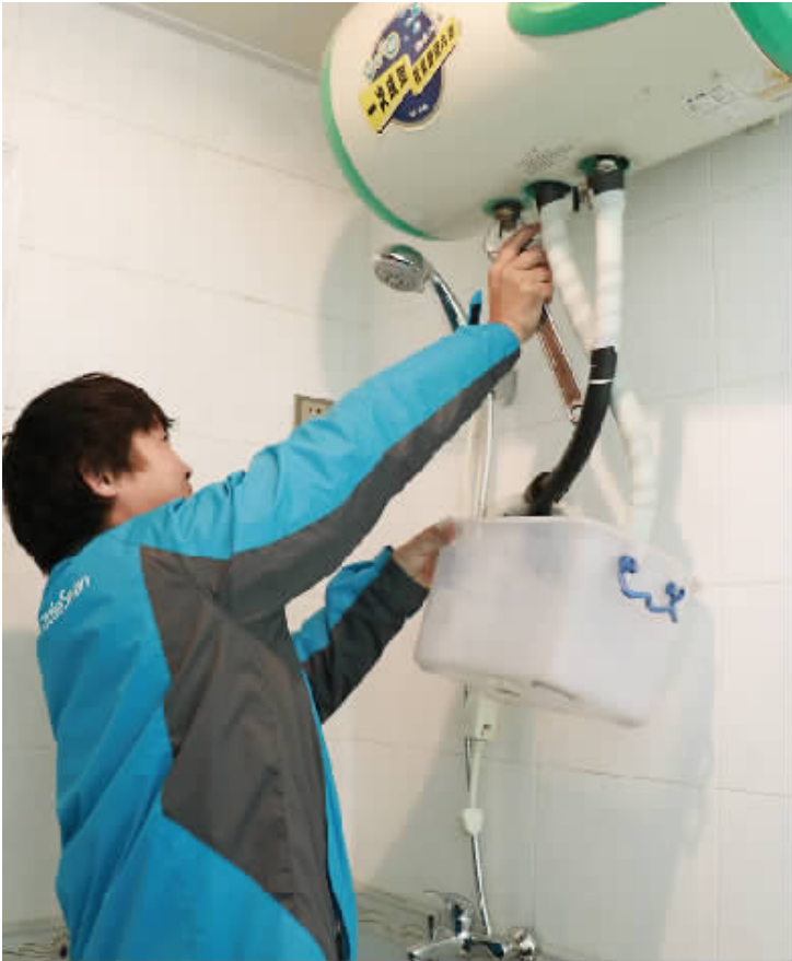
▲ 电热水器的排污口就在热水出口旁。
