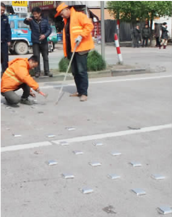
公路养护人员在东永一线清理破损减速道钉。
