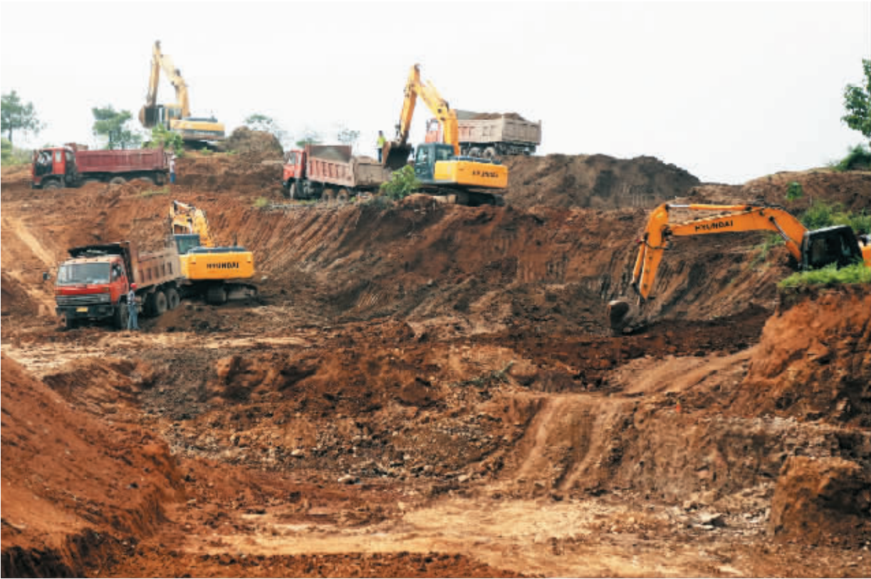
图为丽州南路延伸工程施工现场
